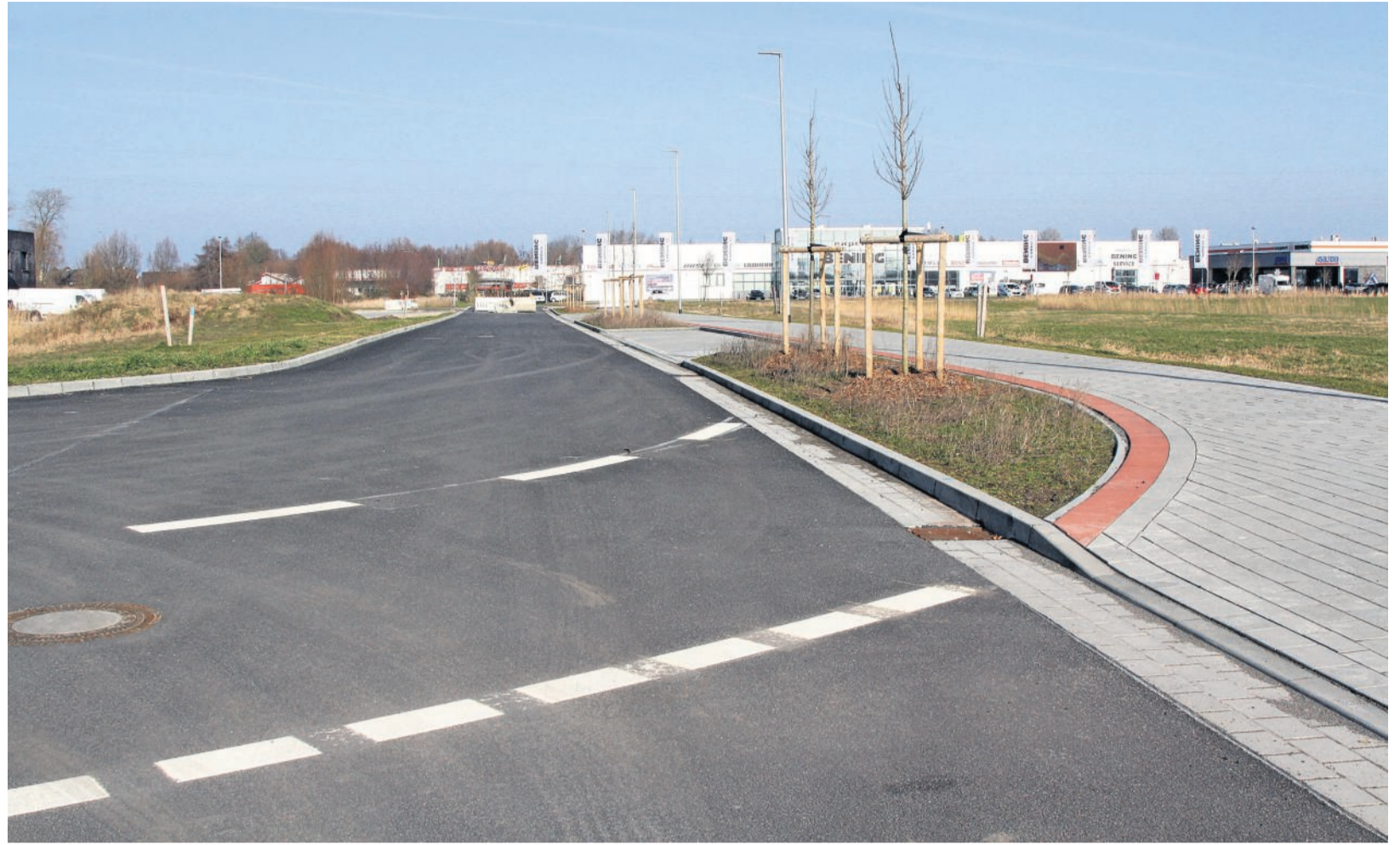
Im Gewerbegebiet „Am Böhlgraben“ möchte die Stadtverwaltung gern ein Sondergebiet für großflächigen Einzelhandel ausweisen. Das Sortiment des Marktes soll jedoch nicht in Konkurrenz zur Innenstadt stehen. Foto: Reese-Winne
